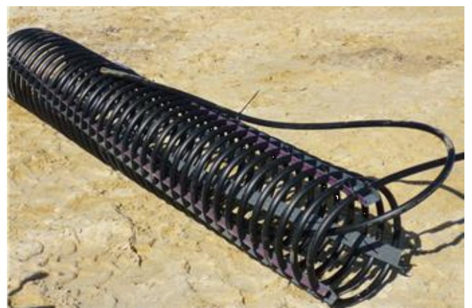
Abb. 5: Für Kollektoren gibt es unterschiedliche Bauweisen, hier abgebildet ist ein Spiralkollektor. Foto: Panteleit/GDfB
