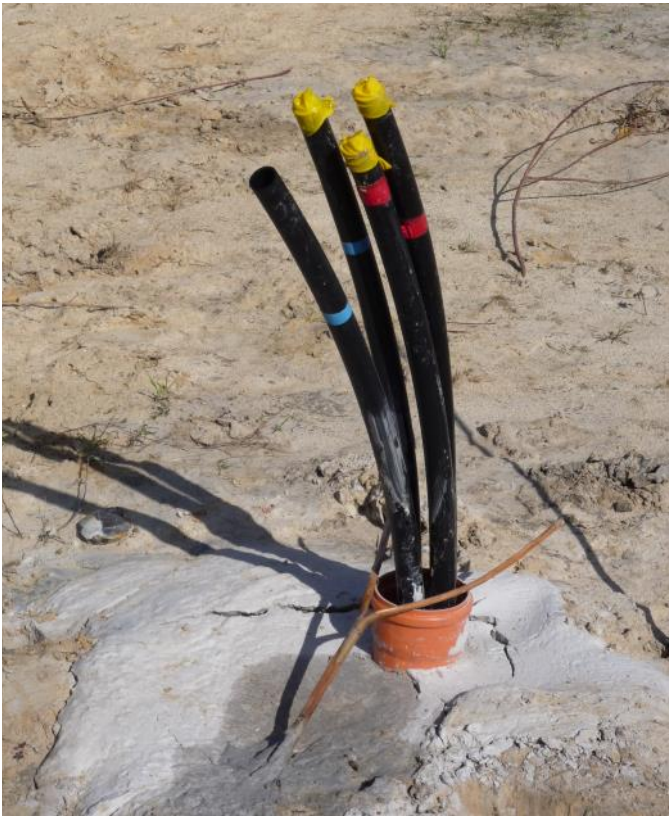
Abb. 15: Vollständig hinterfüllte Doppel-U-Erdwärmesonde. Foto: Panteleit/GDfB
