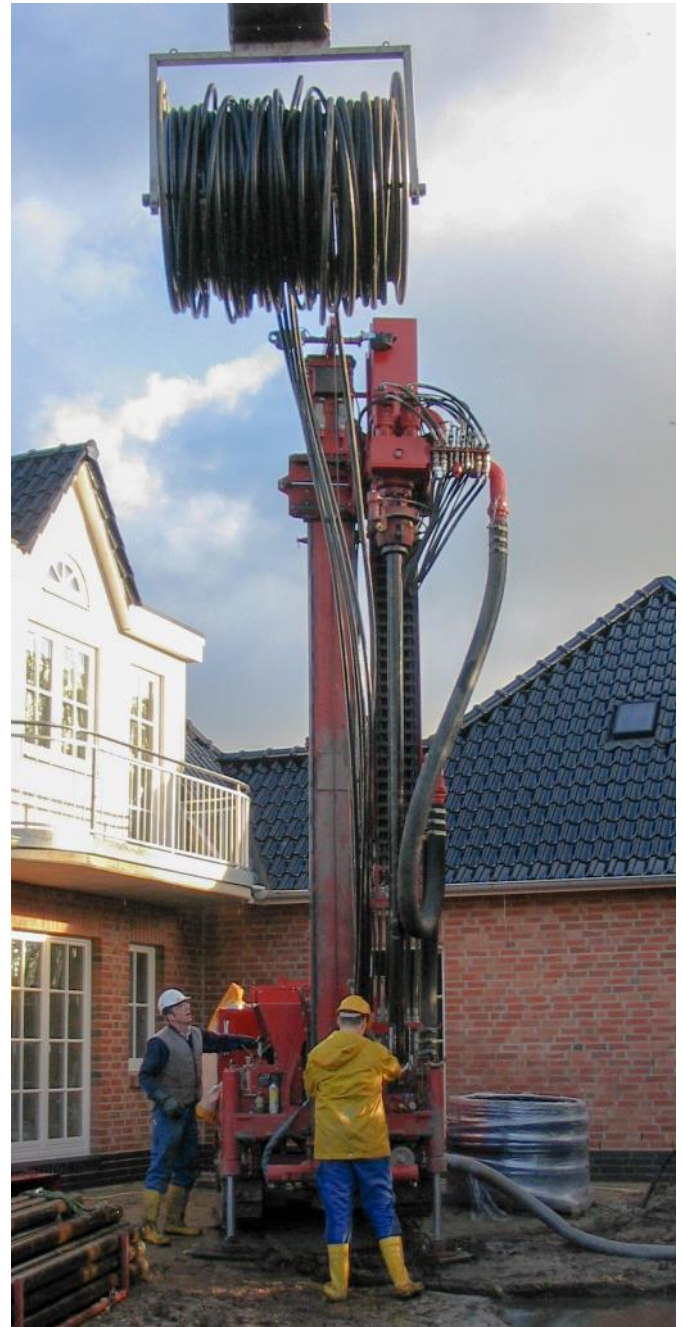
Abb. 14: Einbau einer Erdwärmesonde, hängend von der Haspel. Foto: Panteleit/GDfB
