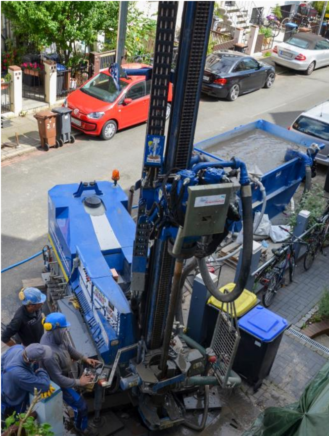
Abb. 13: Bohrarbeiten zur Errichtung einer Erdwärmesonde vor einem Altbremer Haus. Foto: von Gleich
