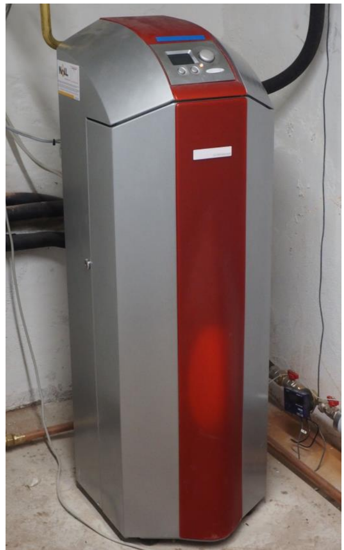
Abb. 2: Aussehen und Funktionsschema einer Wärmepumpe. Grafik/Foto: Panteleit/GDfB
